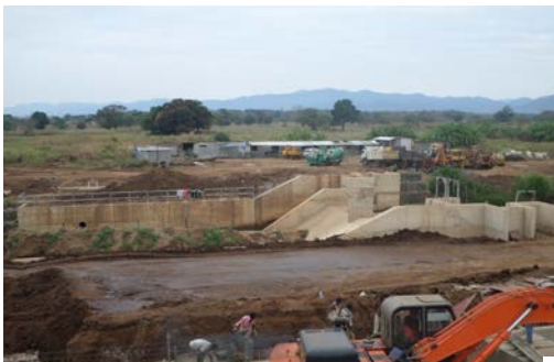
Ujenzi wa Skimu ya Umwagiliaji Kata ya Itete, Wilaya y Kilombero Mkoa wa Morogoro
