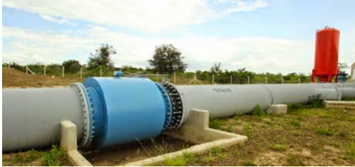
Bomba ya maji safi na salama kutoka mtambo wa kuzalisha maji wa Ruvu Chini, Wilaya ya Bagamoyo
